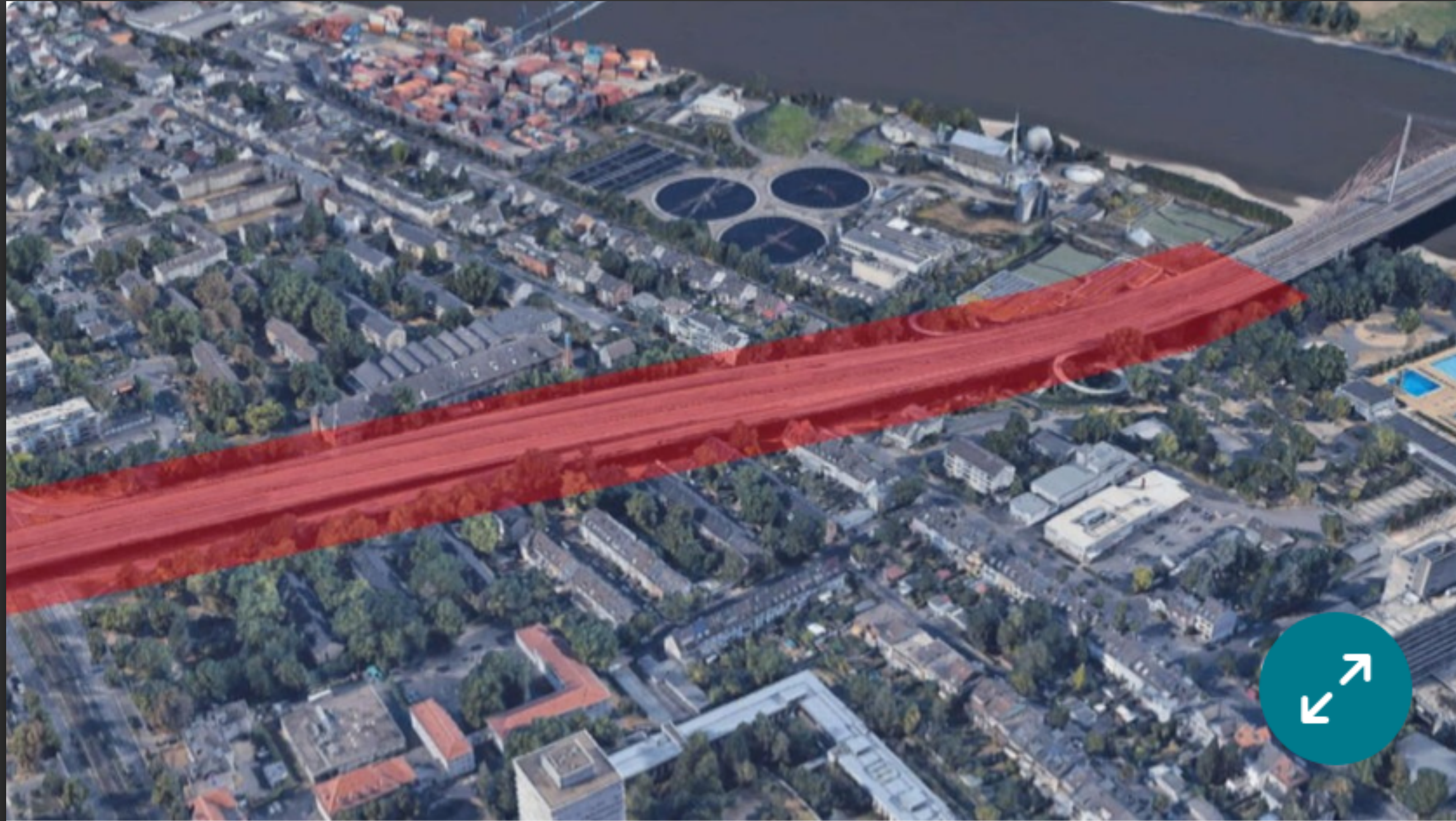
Die linksrheinische Vorlandbrücke der Nordbrücke
