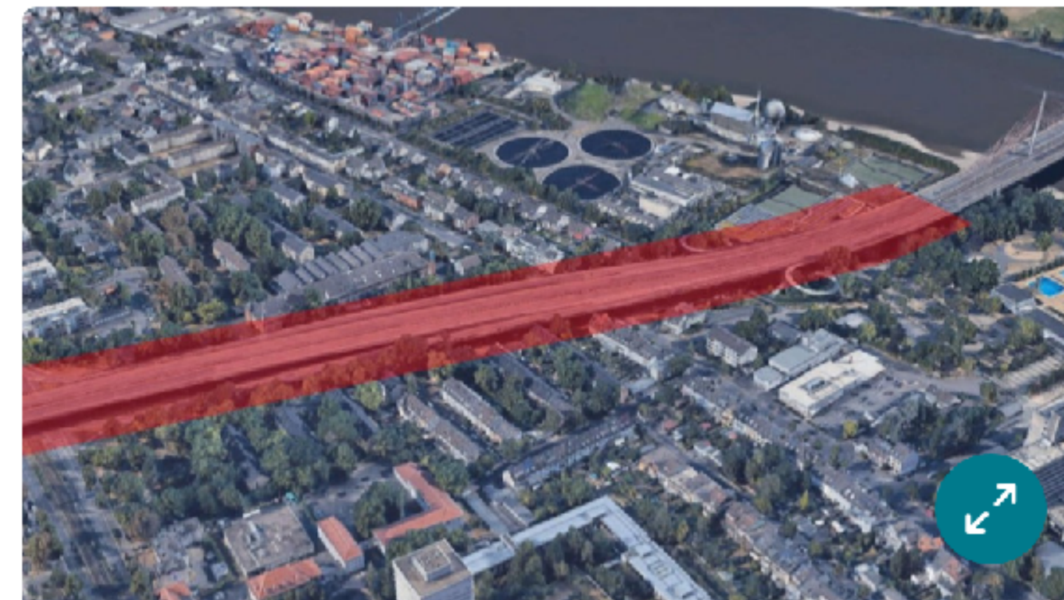
Die linksrheinische Vorlandbrücke der Nordbrücke
